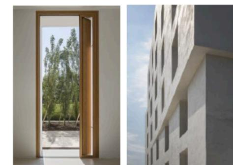
Abb. A. 6: Lüftungsflügel bei raumhohen Fenstern, Kalkputz
