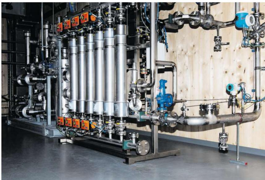
In dieser Anlage wird das Methangas aus dem Bioreaktor vor dem Einspeisen ins Netz aufbereitet.
