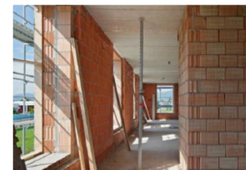
Abb. A. 5: Rohbau mit Wienerberger Mauersteinen
