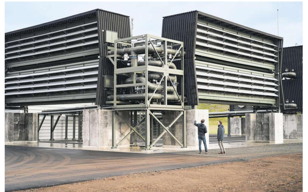
Die Orca-Anlage von Climeworks auf Island filtert jährlich 4000 Tonnen CO<sub>2</sub> aus der Luft.
