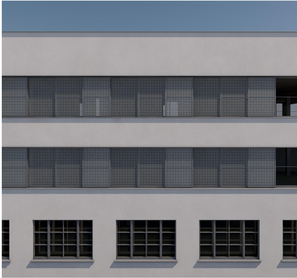
Schiebeläden in geschlossenem Zustand
