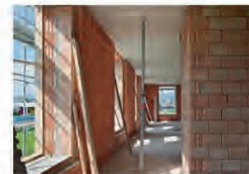
Abb. A. 5: Rohbau mit Wienerberger Mauersteinen
