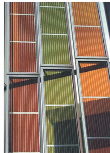
5 Transluzente Graetzel-Photovoltaikzellen werden demnächst am Swiss Tech Convention Center zum Einsatz kommen (vgl. S. 19). | Les cellules photovoltaïques translucides Graetzel vont être montées prochainement au Swiss Tech Convention Center (v. p. 19). | Le celle fotovoltaiche di Graetzel, trasparenti, troveranno presto impiego nel Swiss Tech Convention Center (cfr. pag. 19).
