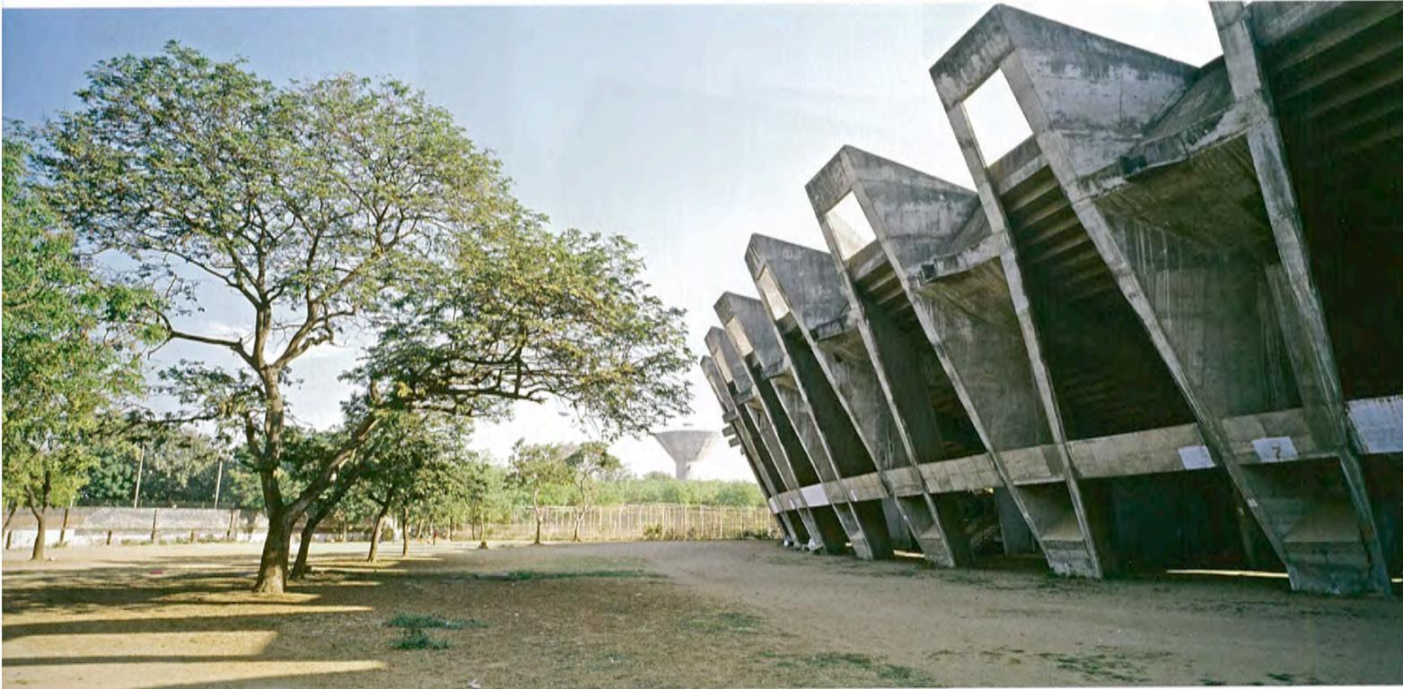
Betonfaltwerk-Segmente bilden die Arena
