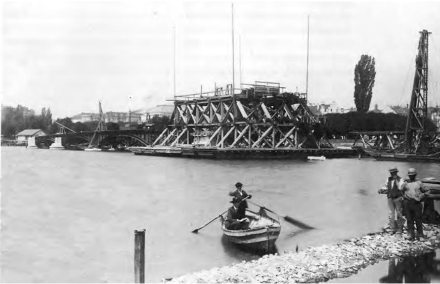
**Gerüst der grossen Taucherglocke für den Bau der Brückenpfeiler**
