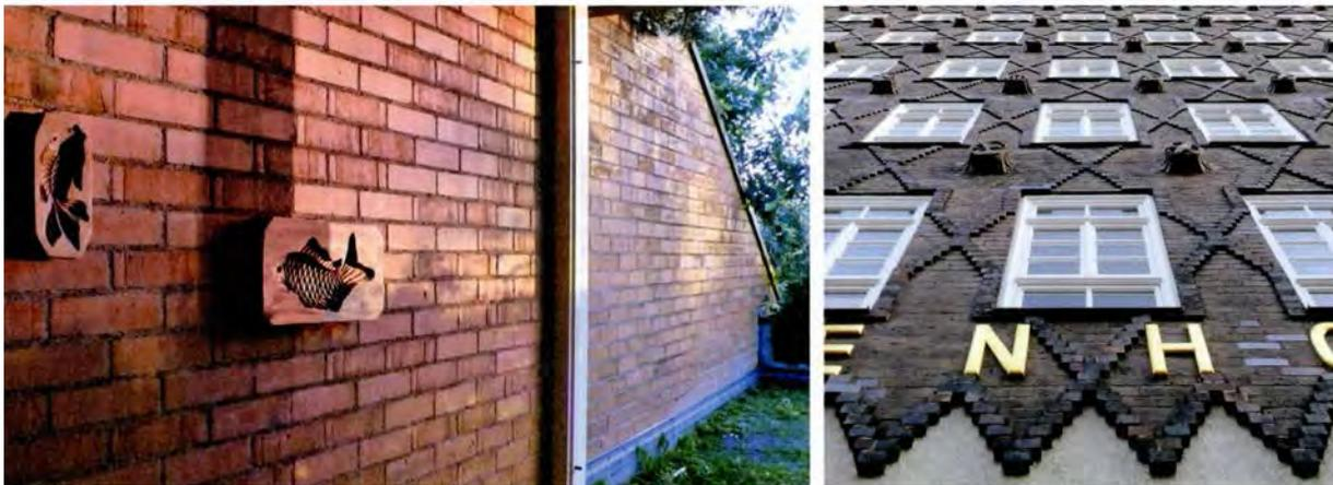
Im Mehrfamilienhaus von Paillard Jaray Leemann (Zürich, 1959) sind sämtliche Wände, äussere wie innere, aus Sichtbackstein gemauert, wobei Fussortierung und Sichtseite in kunstvoller Absichtslosigkeit abwechseln. Bündig abgezogene Mörtelfugen betonen noch den muralen Charakter und tragen
