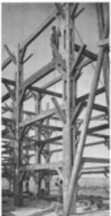
Stützen und Untergiebel des selbstständigen Industriehallen, Bauweise Götting
