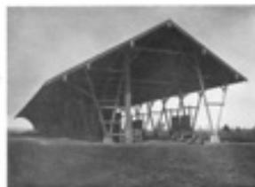
Feldkassette mit einseitigen Yordach, gute Zulaufentlastung (Joh. Drenowal) zur Sicherung der Stützen gegen Freigiebel; Untergurtung verbleibt einseitig; Gehst von der Bauweise des oberen Innenraums
