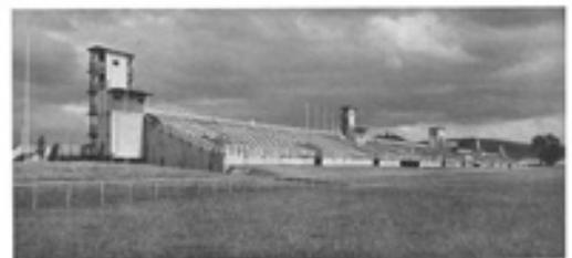
Tribüne, ebenfalls mit Einbauten auf Stützen und Wiederentdeckung des Holzes erbaut für das Deutsche Turnfest in Stuttgart 1933, Arch. Paul Bonatz, Stuttgart
