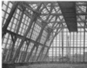
Innenansicht des Silospeichers (siehe unten), Handwerklich durchgeführte Halle von rund 15 m Spannweite
