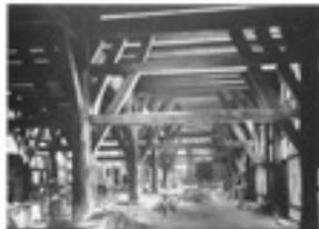
Erdgeschoss des Bauwerks in Ellingen (gebaut 1420). Der Bau ist in eine klare Ordnung von Bandplanken (Stützen) eingeteilt. Ein Band geht immer durch die ganze Fachwerksreihe durch. Die zwischen die stehenden Planken eingespannte Wand ist ein Baumstamm und überzieht seine Kräfte. Vergleiche S. 112 oben links
