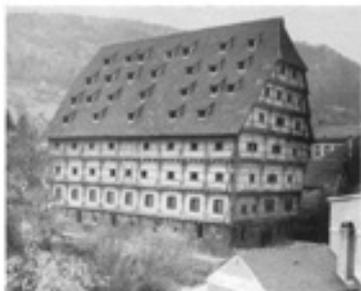
„Kammlerei“ in Göttingen (gebaut um 1300), abnorme Bauweise. — Rechts: Stützen und Untergiebel in „Neuen Bau“ in Schwab. Hall (gebaut um 1525). Stützen, Rippe und Schopfböden decken das obere Fach
